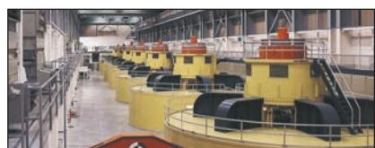
Мал. 1. Турбінний зал ГЕС. Турбіною називають двигун із лопатями, який надає рух валу генератора під тиском пари або води.
